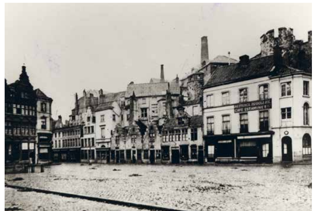
Différentes images de la seconde moitié du XIX e siècle, mais antérieures à 1889, quand la démolition des maisons autour du château des Comtes a commencé. Sur l'une d'elles, on voit clairement deux cheminées d'usine. (Archives de la ville de Gand)
